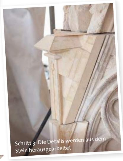
Schritt 3: Die Details werden aus dem Stein herausgearbeitet
