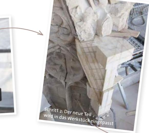
Schritt 2: Der neue Teil wird in das Werkstück eingepasst
